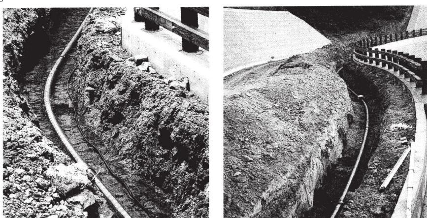
写真1.5.2 直管による曲げ配管
