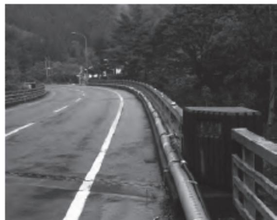
写真 3.9.2 橋梁部への固定
