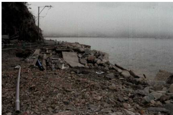
図5 釜石市の被害を受けた道路と管路
