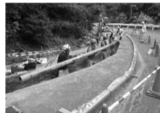
写真 3 既設管撤去状況
