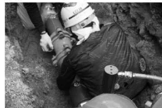
写真 4 メカニカル接合状況
