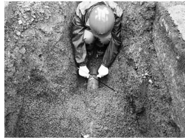
写真 1 外径寸法測定状況
