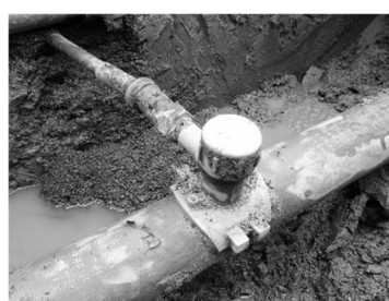
写真4 掘削状況(分岐部)
