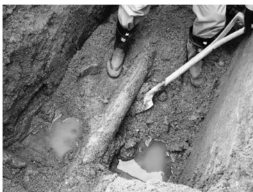
写真3 掘削状況(直管部)
