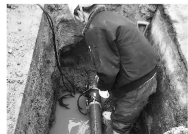
写真8 EF接合状況
