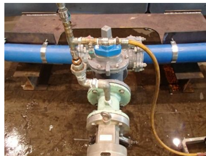
写真 1 施工性試験 (呼び径 100mm 穿孔)
