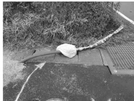
写真 2 HPPE 管からの仮設配管状況 (露出部は他管種)
