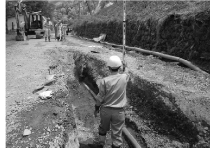
写真5 垂直方向変位測量状況
