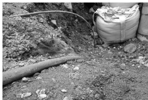
写真4 塩島地区青ポリ管堀上げ状況
