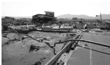
写真 6 流出した管路
