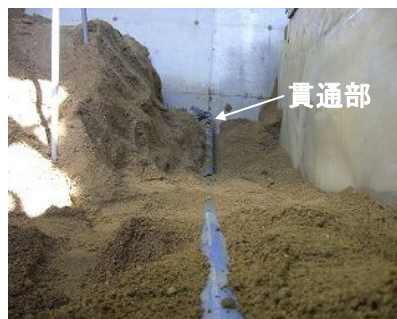
図2：沈下状況
