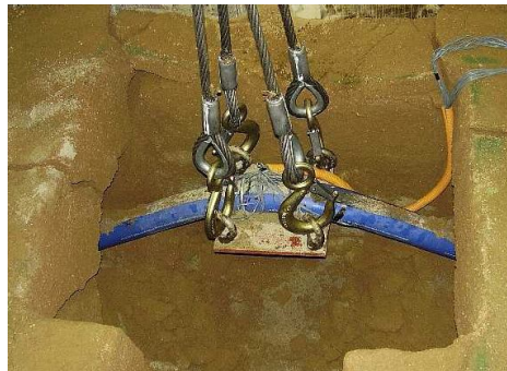
図3：吊り上げ状況(幅100mm)
